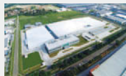
上空からの全景
