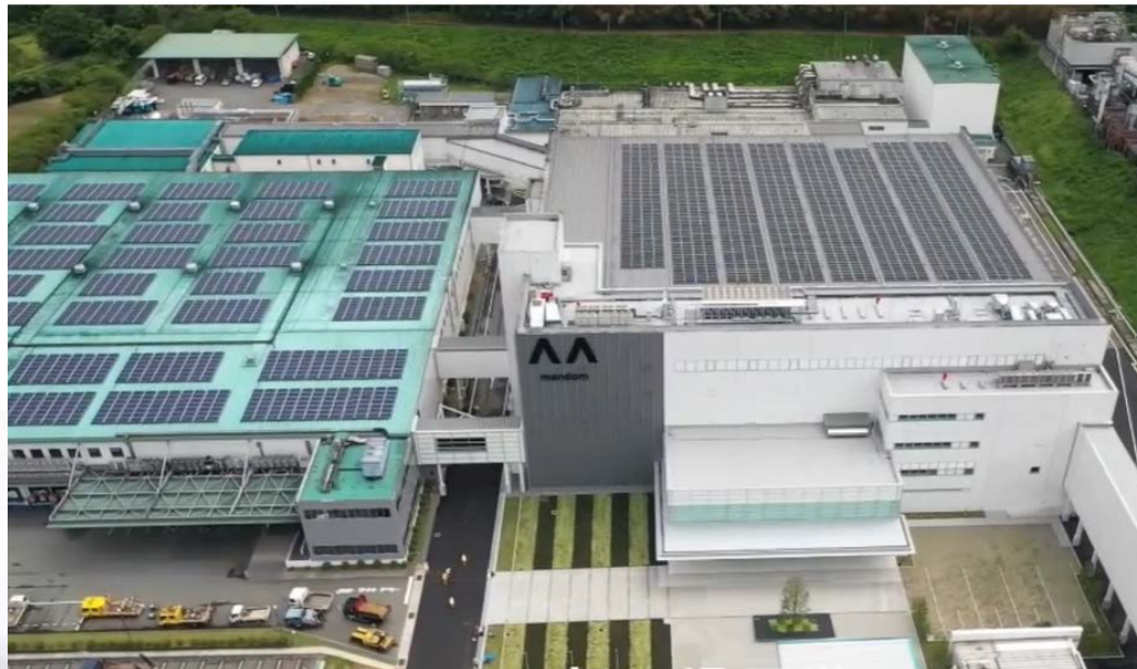
上空から 天井には太陽光発電パネル
