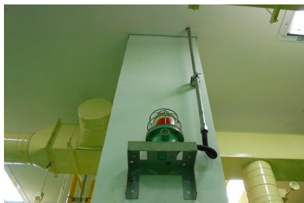
写真 3-2-4 ガス検知パトライト
