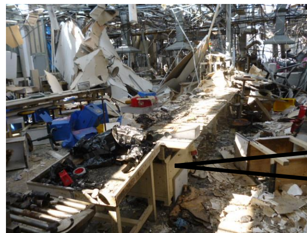
写真 4-2-13 熱風機損傷部 (D 視)
