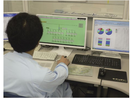
福崎工場のエネルギー監視システム
